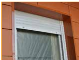
Linteau, tableau sur bardage
