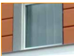
Linteau, tableau sur bardage
