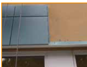
Pose de cassettes
