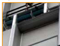
Cadre de pose sur bardage
