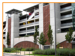
Façade en bardage
