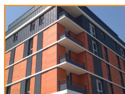
Façade en bardage
