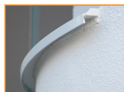
Goutte d'eau cintrée
