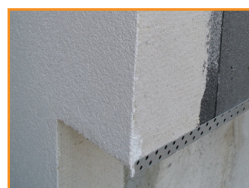
Isolant sur rail de départ
